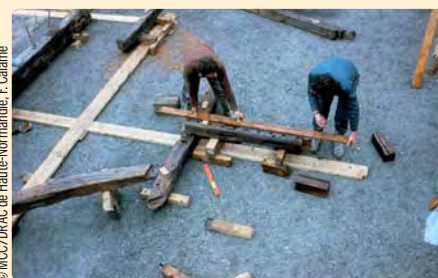
Charpentiers disposant les bois d'une ferme sur blochet au-dessus de l'épure matérialisée au sol.
